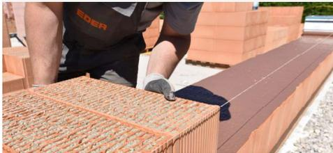
EDER Vollwertziegel werden wie herkömmliche Planziegel mit Deckelmörtel verarbeitet. Durch das geringe Stückgewicht der EDER V38 Vollwertziegel, werden diese noch schneller gesetzt.
