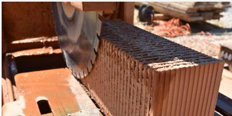
Vollwertziegel können beliebig in Höhe, Länge und Form, am besten mit einer Ziegelschneidmaschine mit Nassschnitt, geschnitten werden. Der Füllstoff lässt sich mitschneiden und bleibt dabei im Ziegel.
