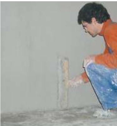
Bis zur Rohdecke verputzen!
