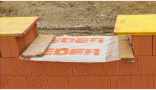
Abdeckung der Ziegelschar verhindert Eindringen des Regenwassers
