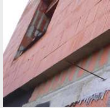
Vorsprünge mit Mörtel verschließen
