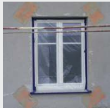
1. Diagonalarmierung
