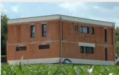
Hochlochziegel mit Isoliermörtel vermauert
