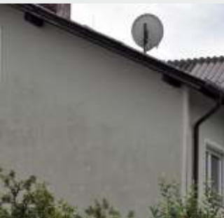
... können sich auf Fassade abzeich
