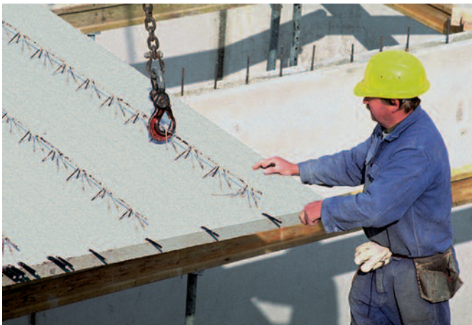
Bild 12: Verlegen der Deckenelemente
