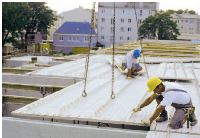
Bild 8: Verlegen der Deckenelemente
