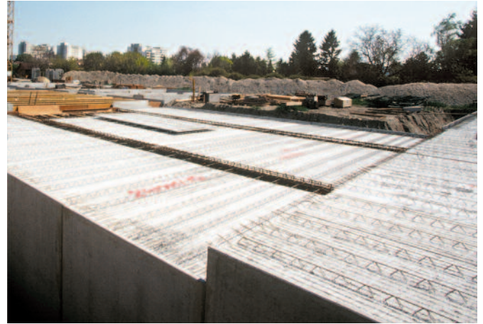
Bild 16: Fertig verlegte Elementdecke
