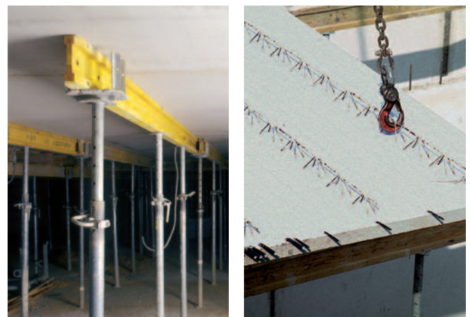
Bild 3 und 4: Montageunterstellung
