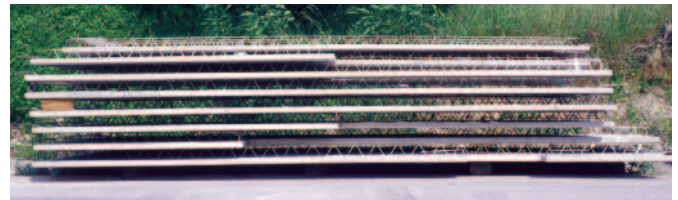
Bild 7: Lagerung der Deckenelemente
