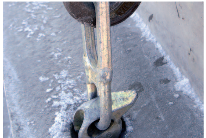
Bild 5: Anschlagen der Treppe am Transportanker
