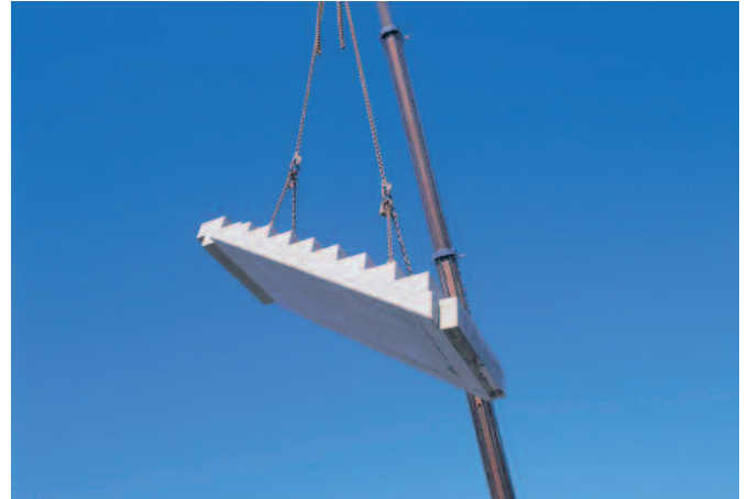
Bild 10: Beton-Fertigteiltreppe am Montagekran
