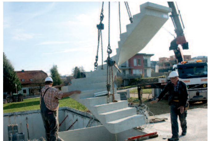
Bild 11: Einheben der Treppe in Montagelage
