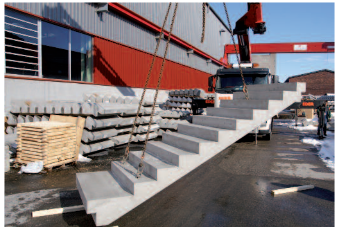
Bild 8: Einheben einer Beton-Fertigteiltreppe
