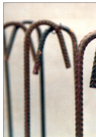
Bild 3: Steckseisenendhaken zur Wandmitte ausrichten
