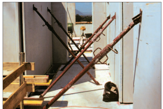
Bild 16: Sicherung der Wandelemente mit Schrägstützen
