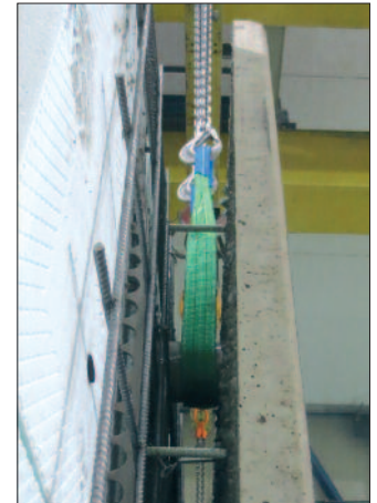
Bild 4 und 5: Element an den vorgesehenen Anschlagmitteln anhängen
