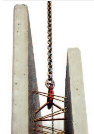
Bild 4 und 5: Element an den vorgesehenen Anschlagmitteln anhängen
